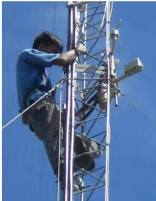
Gambar 3. Pemasangan anemometer PCE-FWS20
