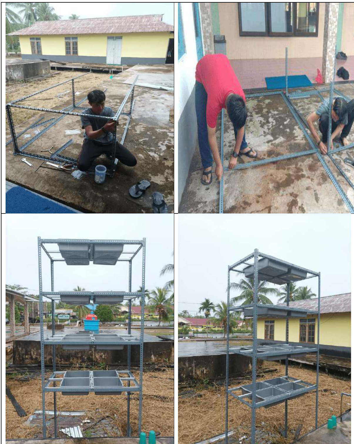
Gambar 4. Pemasangan multi tray aerator di lokasi PKM
