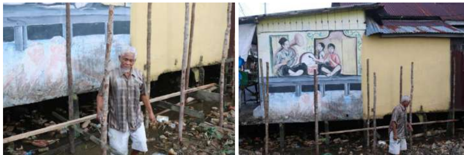
Gambar 4. Proses Pemasangan Perancah Sumber: Hasil Dokumentasi Tim, 2023
