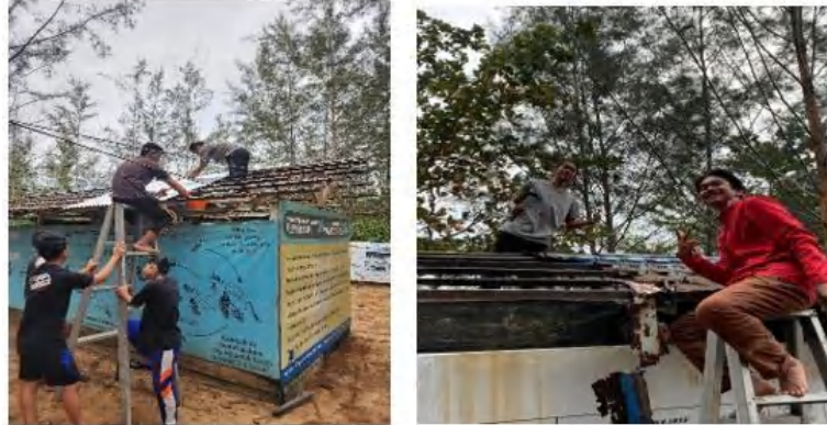
Gambar 4. renovasi atap bangunan penyimpanan tukik
